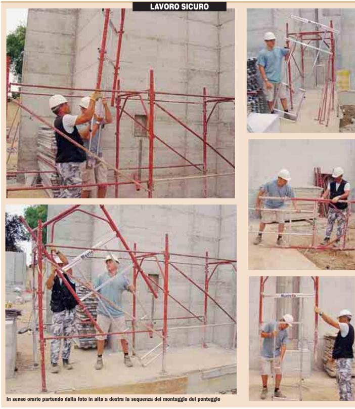
In senso orario partendo dalla foto in alto a destra la sequenza del montaggio del ponteggio
